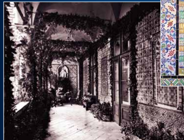
Widok na loggię I piętra, XIX w.
